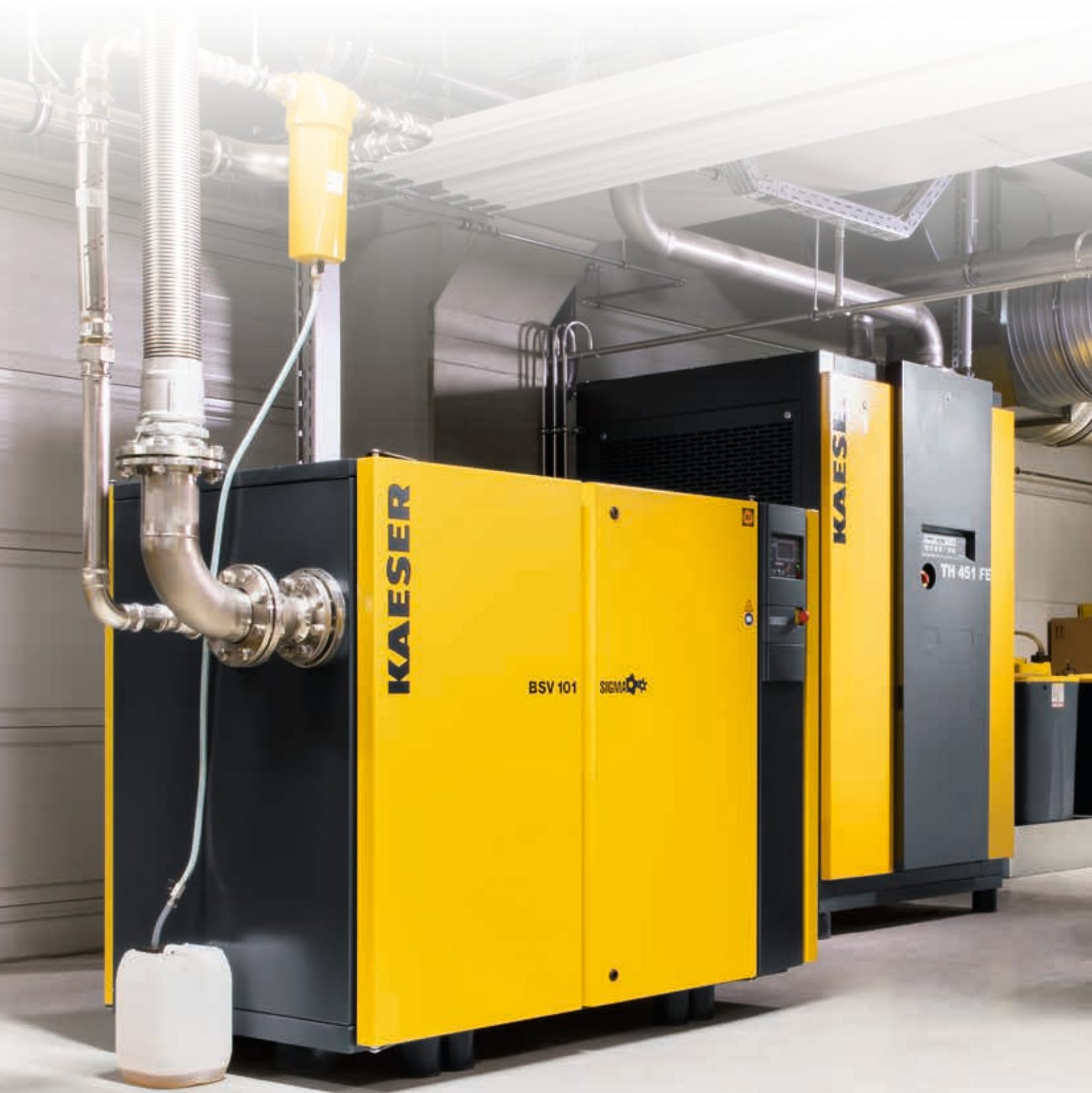
Abb.: Vakuu-Station mit BSV 101
