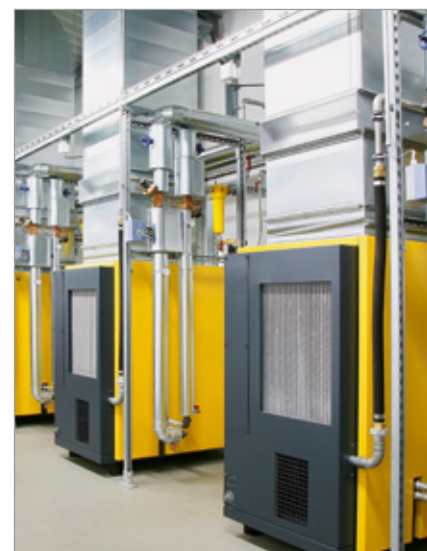
Abb 2: Vorschriftsmäßige Anbindung von Kompressoren an ein Wärmerückgewinnungssystem
