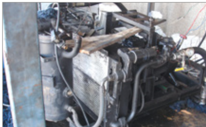
Abb. 1: Vernachlässigte Druckluftstation
