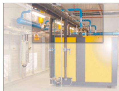
Abb. 3b: Schwingungselastischer Kompressoranschluss mit Axialkompensator
