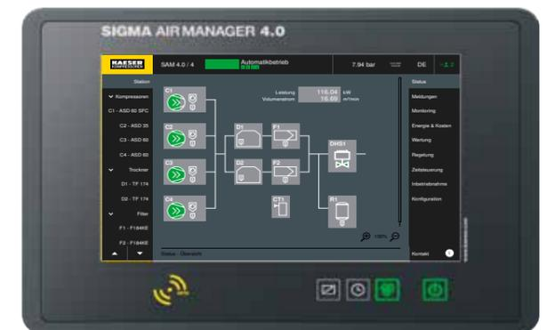
zeigt auf einen Blick, ob sich die Station energetisch im „grünen Bereich“ befindet. Betriebszustände, Druckverlauf, Volumenstrom und Leistung sowie Wartungs- und Störmeldungen werden angezeigt und analysiert – in Echtzeit.
